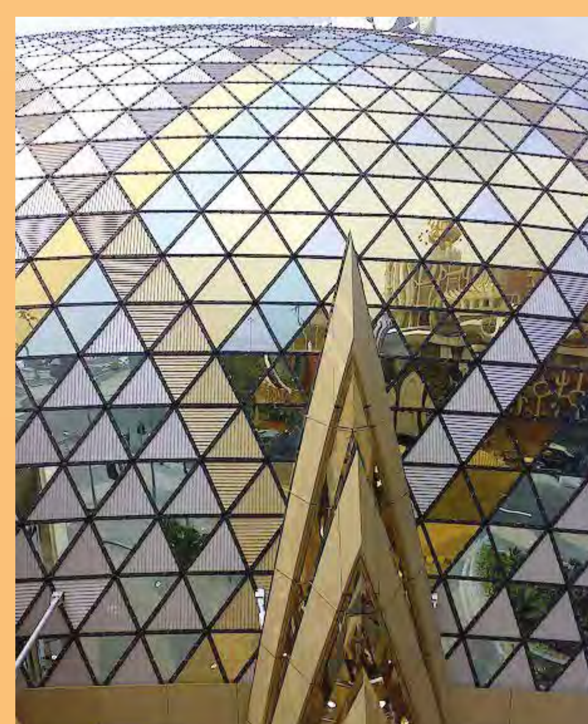
CASINO NEW LISBOA 新葡京娛樂場
